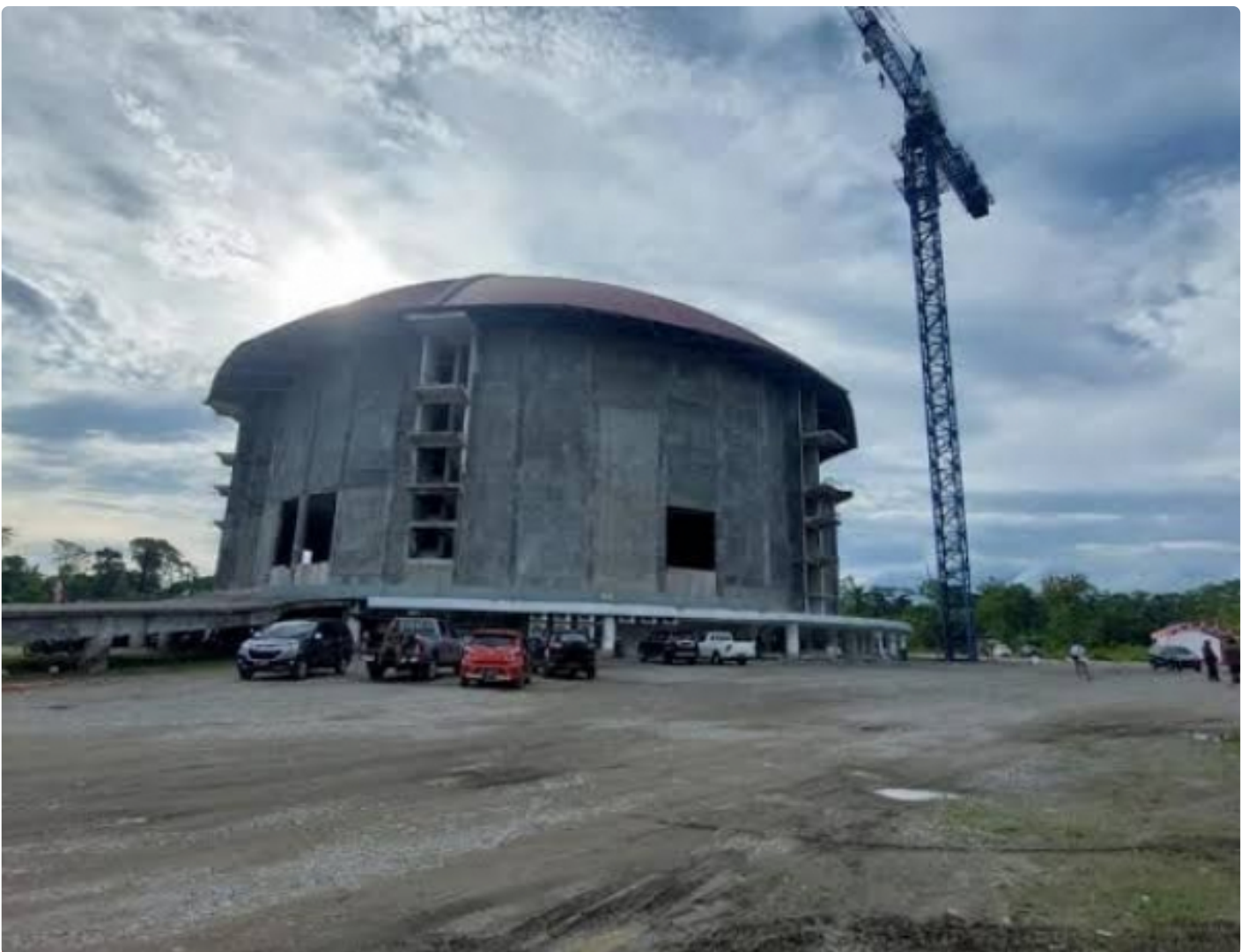
Pembangunan Gereja Kingmi Mile 32
